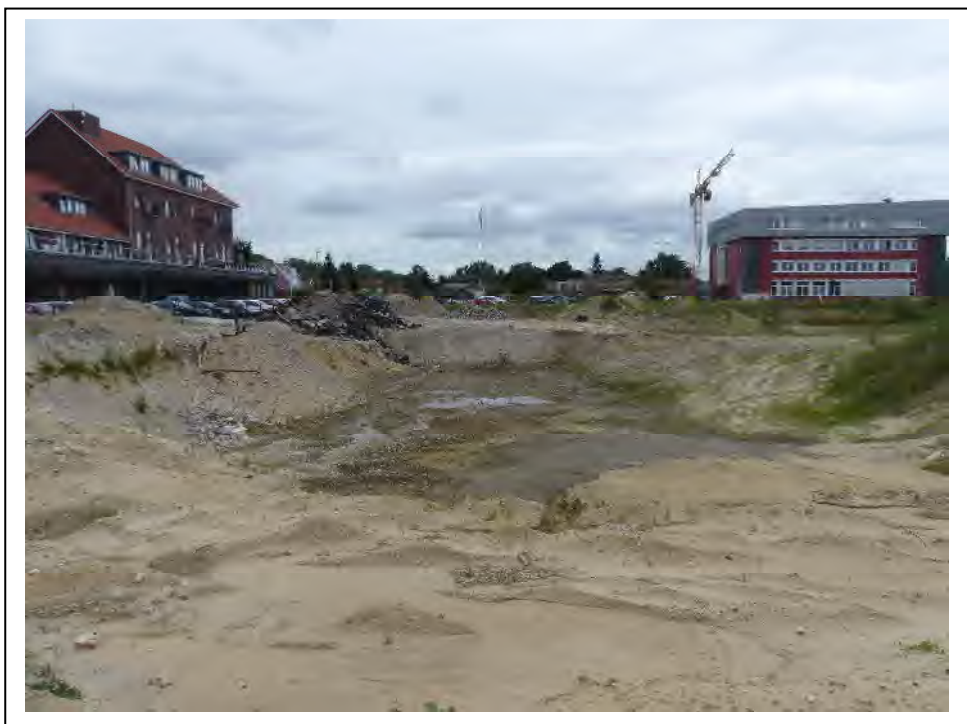
Foto 4: Blick über den nördlichen Grundstücksbereich. Hier wurde der Turm mit Kesselhaus und Unterkellerung bereits abgebrochen. Nördlich der Baugrube liegt ein Bauschutthaufwerk. Blickrichtung Norden (12.06.2018).
