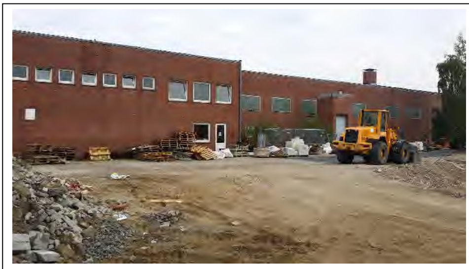
Foto 8: Das verbliebene Gebäude (Milchverarbeitung) im östlichen Teilbereich des Geländes wird im Rahmen der Abbruchmaßnahme als Stellfläche für einige Geräte genutzt (09.08.2018).
