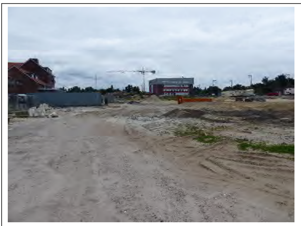
Foto 2: Blick über das Baugrundstück. Zentraler Bereich. Blickrichtung Norden (12.06.2018).
